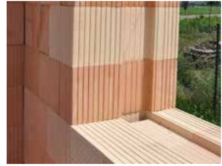
Cegły uzupełniające (K, K-1/2, R) i przykład ich zastosowania w ościeży i parapecie.
