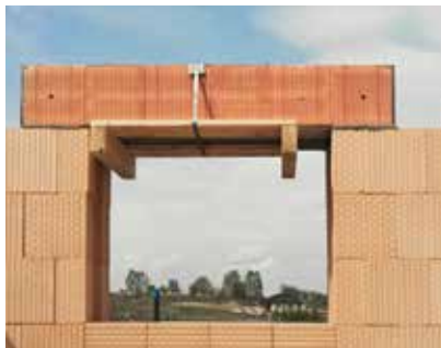
Umieszczenie nadproży (NADPROŻE NOŚNE HELUZ FAMILY 3in1) w podłożu z zaprawy.
