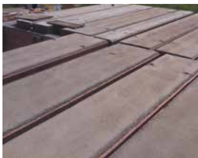
Podparcie stropów MIAKO + podwyższenie/osadzenie paneli stropowych.
