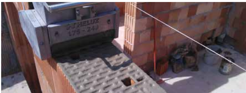
Murowanie wewnętrznych ścian nośnych.
