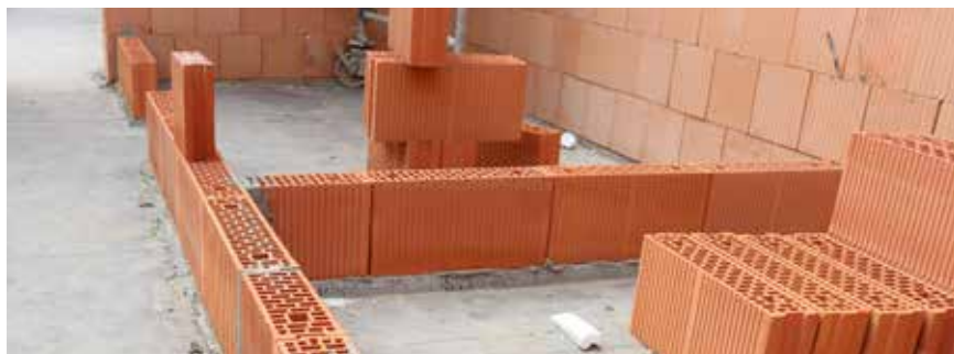
Murowanie ścian nienośnych (ścianek działowych).
