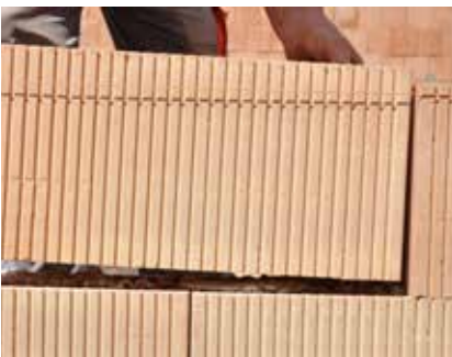
Cegły szlifowane o wysokości 249 mm, optymalne wiązanie wynosi ½ długości cegły, a minimalne 100 mm.
