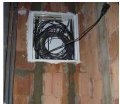
Przed otynkowaniem instalacje powinny zostać odpowiednio pokryte zaprawą.
