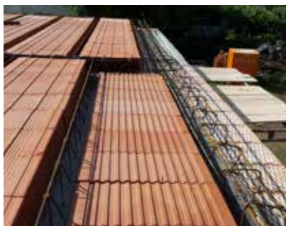
Wykonanie wieńców usztywniających.
