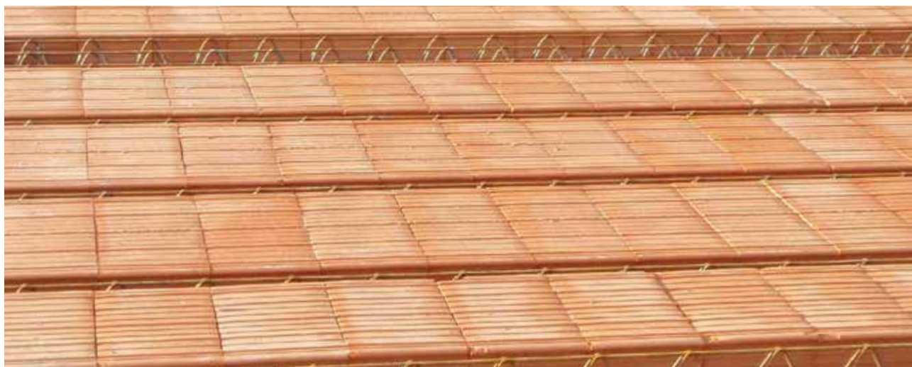
Widok osadzonych belek i wkładek (przed położeniem siatek KARI)
