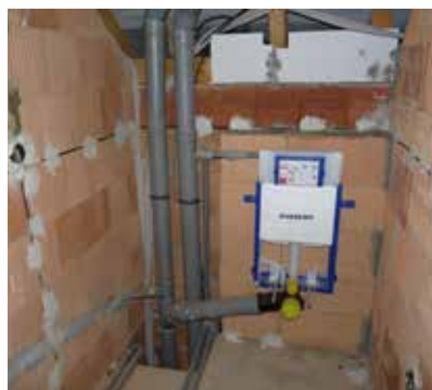
Zalecane jest nie wbudowywanie instalacji wodnych i kanalizacyjnych w mur. W miejscu „pionów” zalecane jest otynkowanie muru przed montażem instalacji technicznych.
