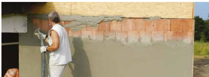
Tynki zewnętrzne.
