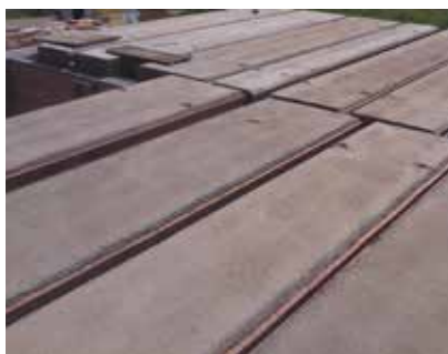
Podparcie stropów MIAKO + podwyższenie/osadzenie paneli stropowych.
