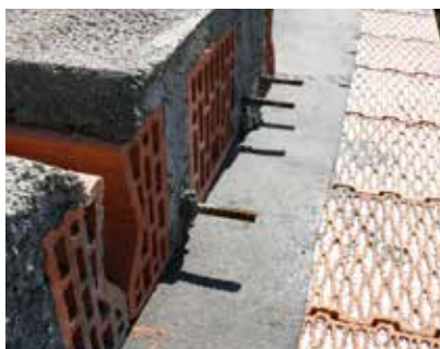
Osadzenie stropów na pasie asfaltowym.
