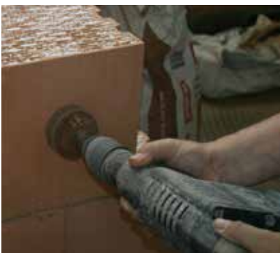
Do wiercenia otworów pod puszkę instalacji elektrycznej zalecane jest użycie wiertła rdzeniowego.
