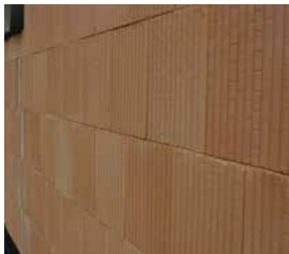
Podłoże murarskie do tynków powinno być płaskie.
