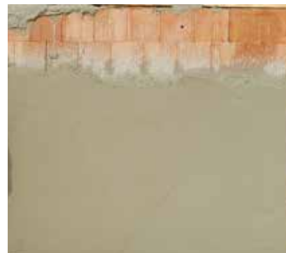
Tynkowanie odbywa się zazwyczaj w dwóch lub trzech warstwach, ręcznie lub maszynowo.
