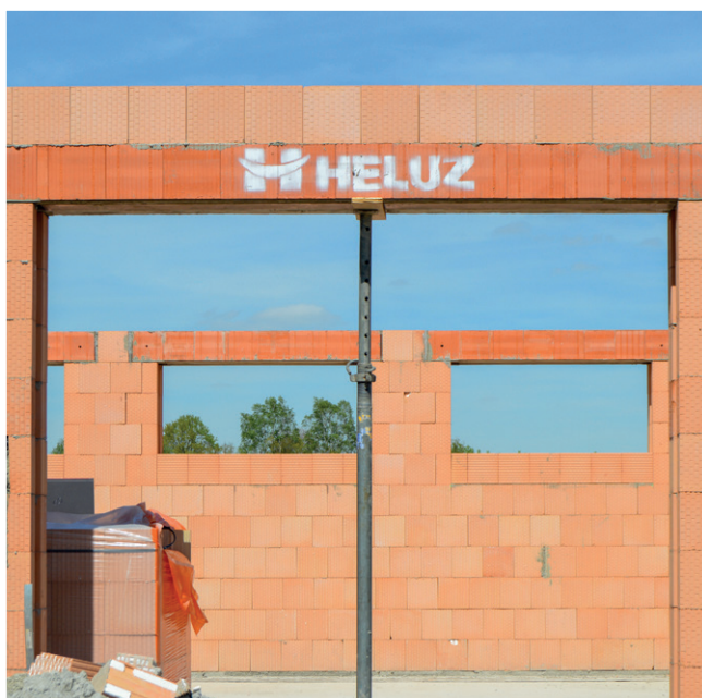
3 Widok z zewnątrz, szczegóły podparcia nadproża o większej długości.
